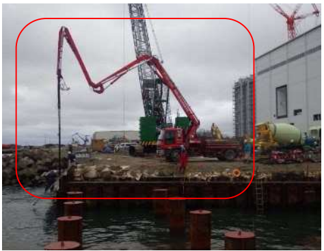
ポンプ車（コンクリート打設）
